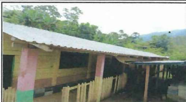
Foto1: Se mejorara las paredes.
