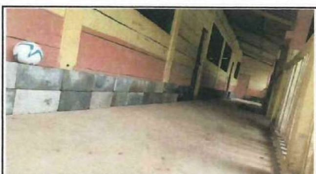
Foto 4: se pintara las paredes.
