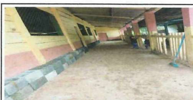
Foto 6: Se pintará el corredor
